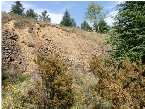
Illustration 31 : Zone de glissement stabilisée sur la banquette
