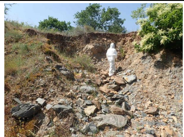
Illustration 34 : Niche d'arrachement et ravine associée sur la banquette n°7
