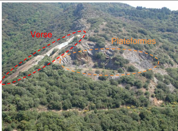
Illustration 17 : Vue générale de la verse et des plateformes de l'ancienne carrière
