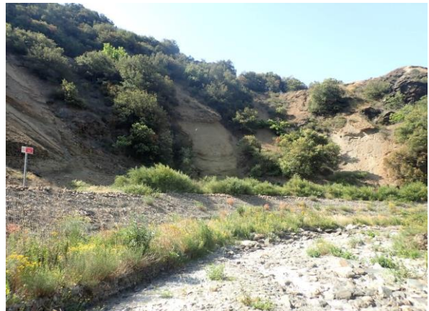
Illustration 20 : Lit du Grésillou en pied de verse, sec, et panneau de restriction d'accès
